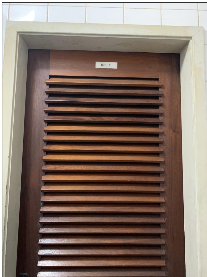
FOTOGRAFIA 47: Vista do depósito privativo nº 11.
