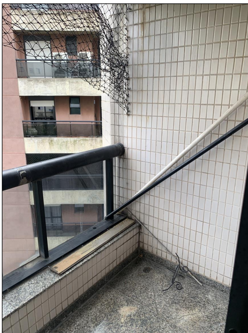
FOTOGRAFIA 42: Vista da varanda da suíte 3.
